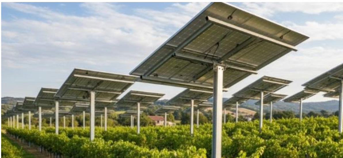
Рисунок 1. Спосіб кріплення сонячної батареї стаціонарно на опорі над ґрунтом.
