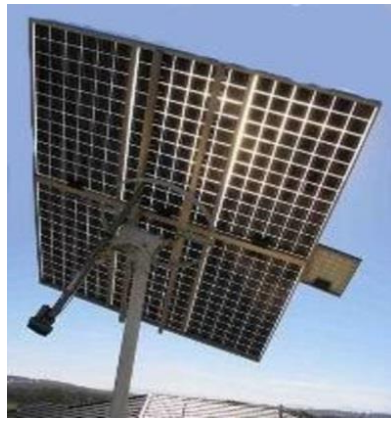
Рисунок 2. Спосіб кріплення сонячної батареї стаціонарно на опорі із сонячним трекером ST1000.
